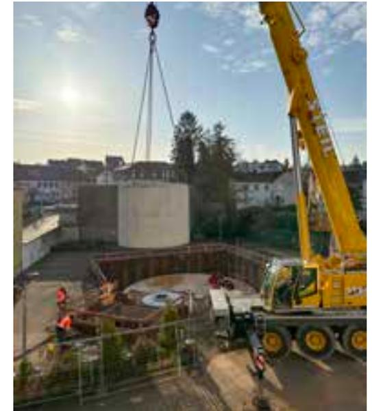
Hier entsteht der Eis-Energiespeicher zur Heizung und Kühlung der Kreissparkasse St. Wendel
